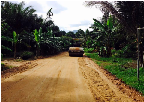
๕. โครงการก่อสร้างถนน คสล.ชอย ๒ บ้านสร้างตนเอง หมู่ที่ ๙
